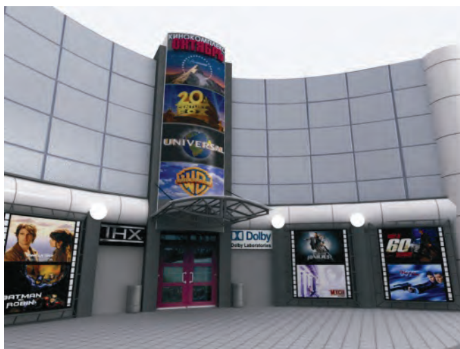
Рис. 1.11. Реконструированный фасад здания кинотеатра «Октябрь»
